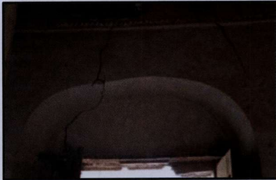
شكل (٢٠): يوضح شروخ في طبقات الملاط والجدران الحاملة لها.
