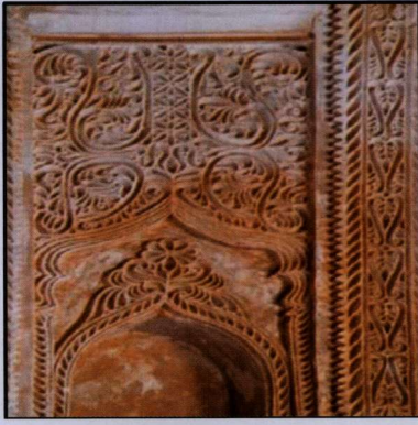
شكل (١٦): يوضح ارتفاع نسبة الرطوبة في الزخارف الجصية وتزهر الأملاح.
