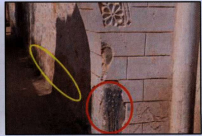
شكل (١٣): يوضح استخدام البياض الإسمنتي مما ساعد في رفع منسوب المياه في الحوائط.
