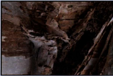
شكل (٢٤): يوضح مظاهر تلف العناصر الخشبية والاصابة الحشرية للآعتاب.
