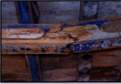
شكل (٢٦): يوضح مظاهر تلف السقف الخشبي والزخارف الملونة عليه.
