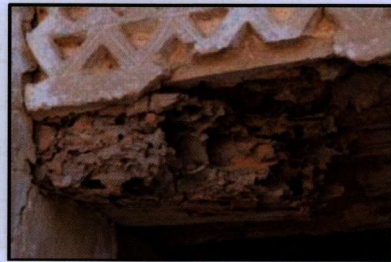
شكل (٢٣): يوضح مظاهر تلف العناصر الخشبية والاصابة الحشرية للآعتاب.
