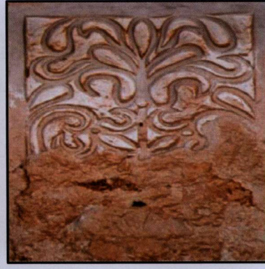
شكل (١٥): يوضح التآكل الشديد في سطح الزخارف الجصية
